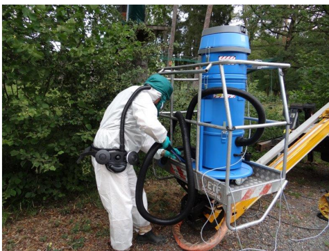
Décontamination du matériel en fin d'intervention - Incinération du sac de l'aspirateur
