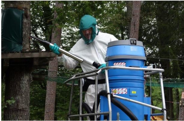
Photos d'un chantier test à Rambervillers en 2020
